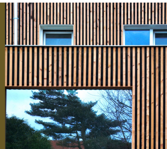
© MARTENS VAN CAIMERE ARCHITECTEN - Bardage en bois certifié FSC traité thermiquement
