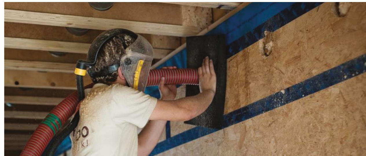
© WOEMA! Isolant insufflé labellisé FSC
