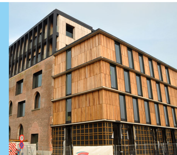
© ESKRA BOUW - Bardage en bois FSC 'projet canal' à Wijnegem
